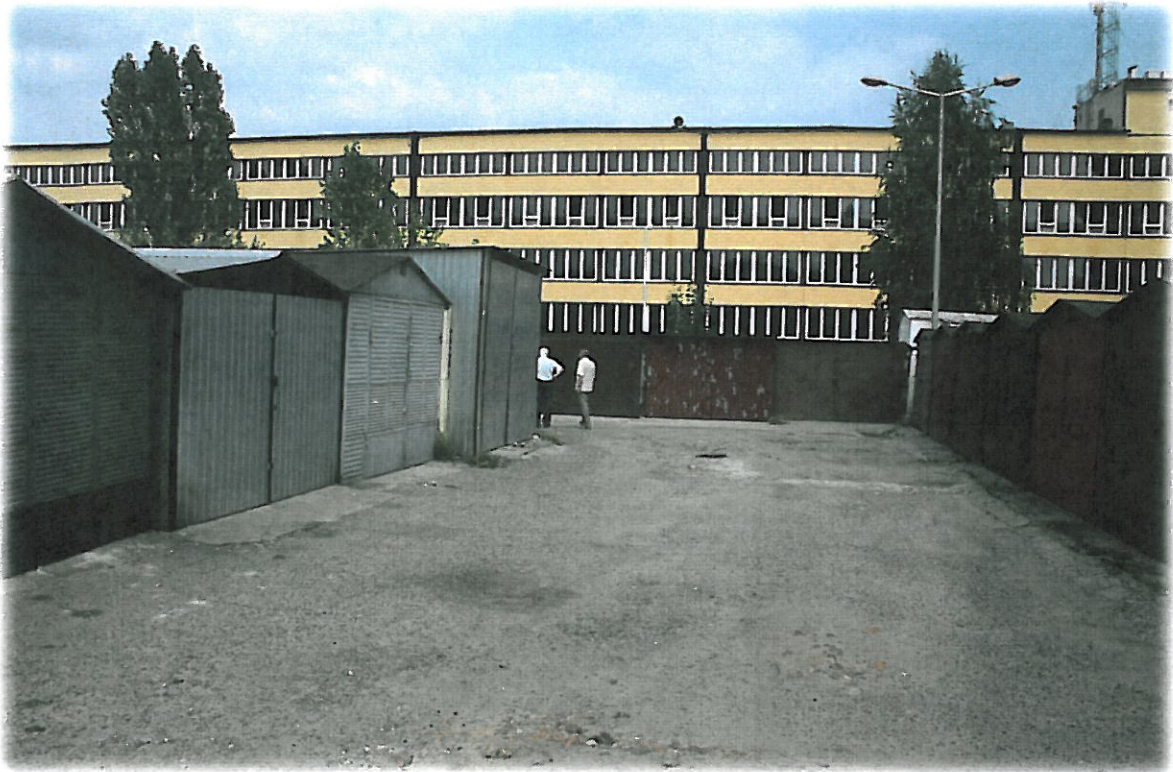
Zdj.7) Garaże - drogi dojazdowe.
