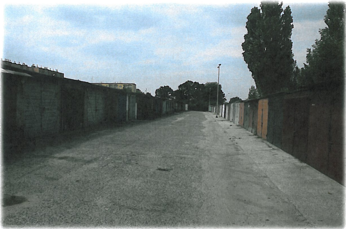
Zdj.9) Garaże - drogi dojazdowe.
