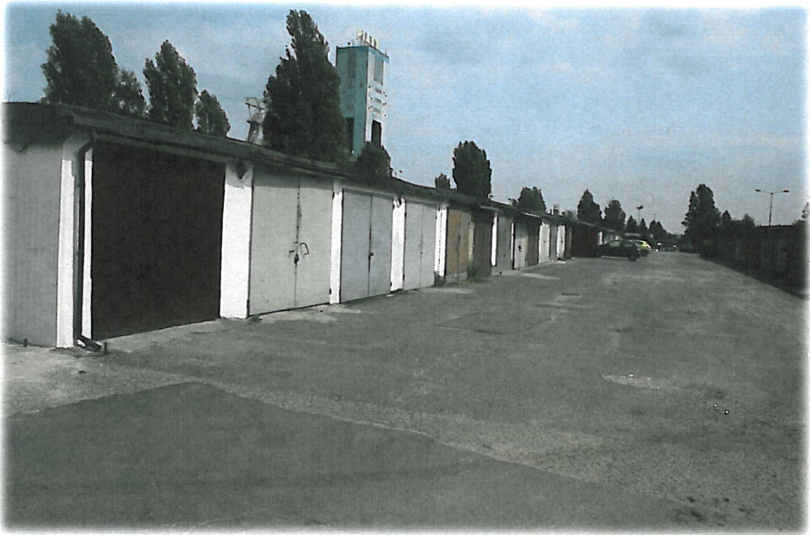
Zdj.15) Garaże - drogi dojazdowe.
