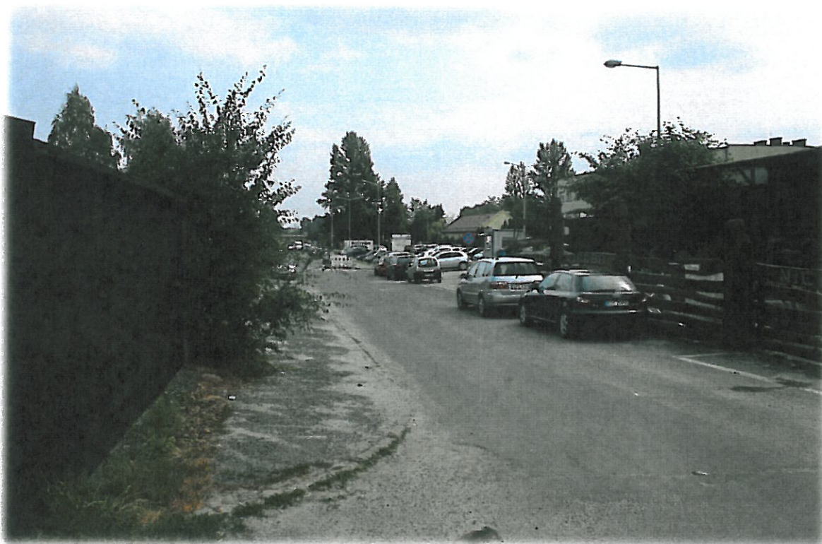
Zdj.5) Garaże - drogi dojazdowe. Rejon budynku nr 22a
