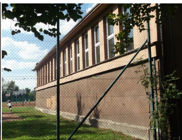
Fot.8 Elewacja południowa - sala gimnastyczna
