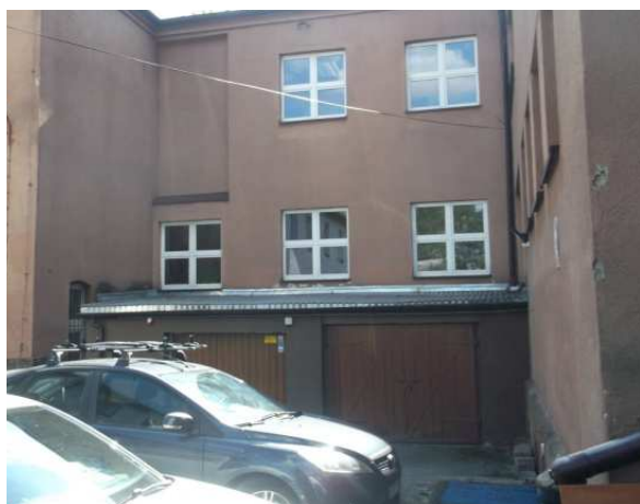
Fot.7 Fragment elewacji północnej
