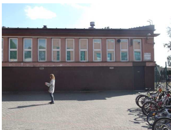
Fot.9 Elewacja północna - sala gimnastyczna
