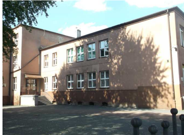
Fot.6 Fragment elewacji południowej
