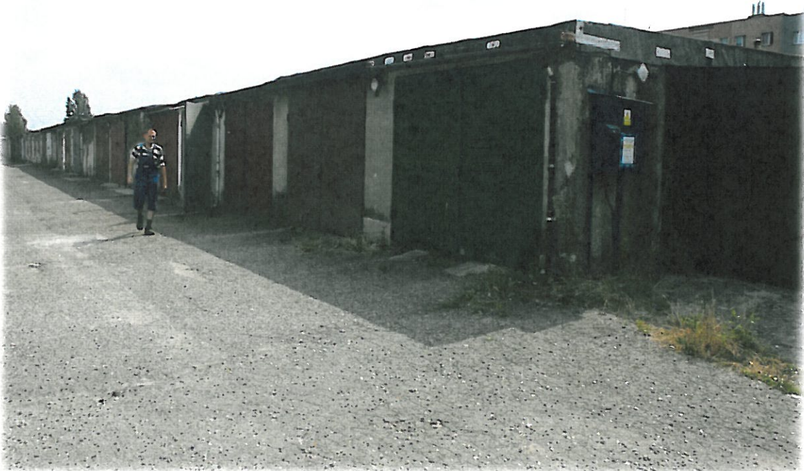
Zdj.12) Garaże - drogi dojazdowe.
