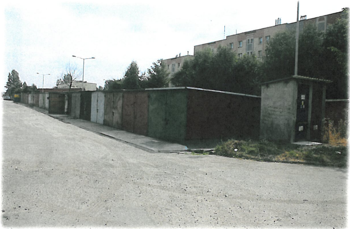
Zdj.17) Garaże - drogi dojazdowe.
