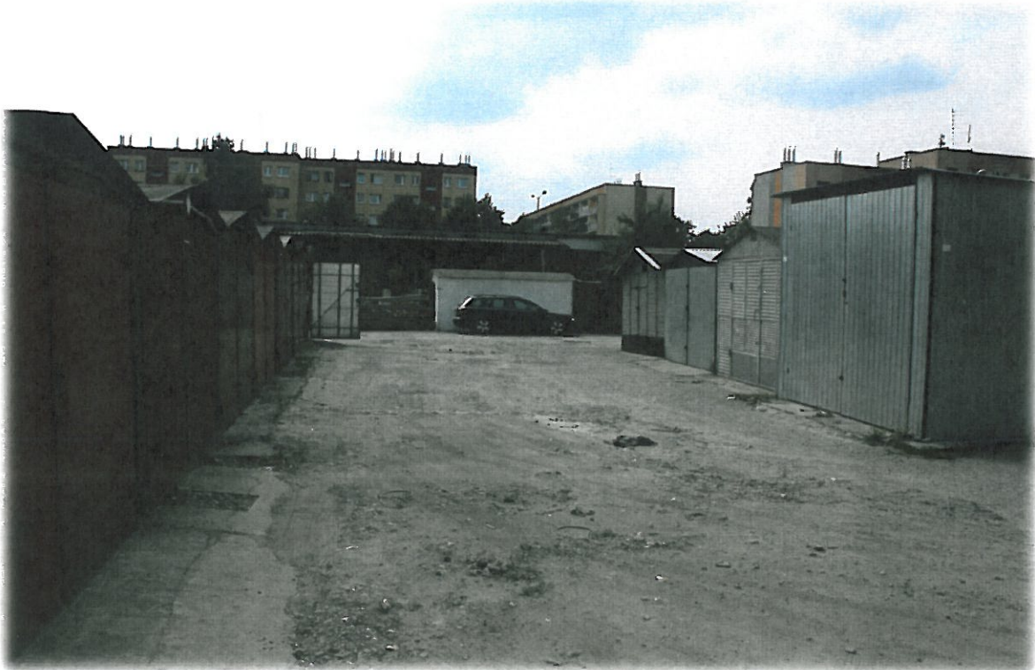
Zdj.8) Garaże - drogi dojazdowe. Widok na budynek nr 22a
