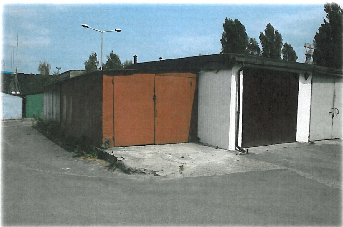
Zdj.14) Garaże - drogi dojazdowe.
