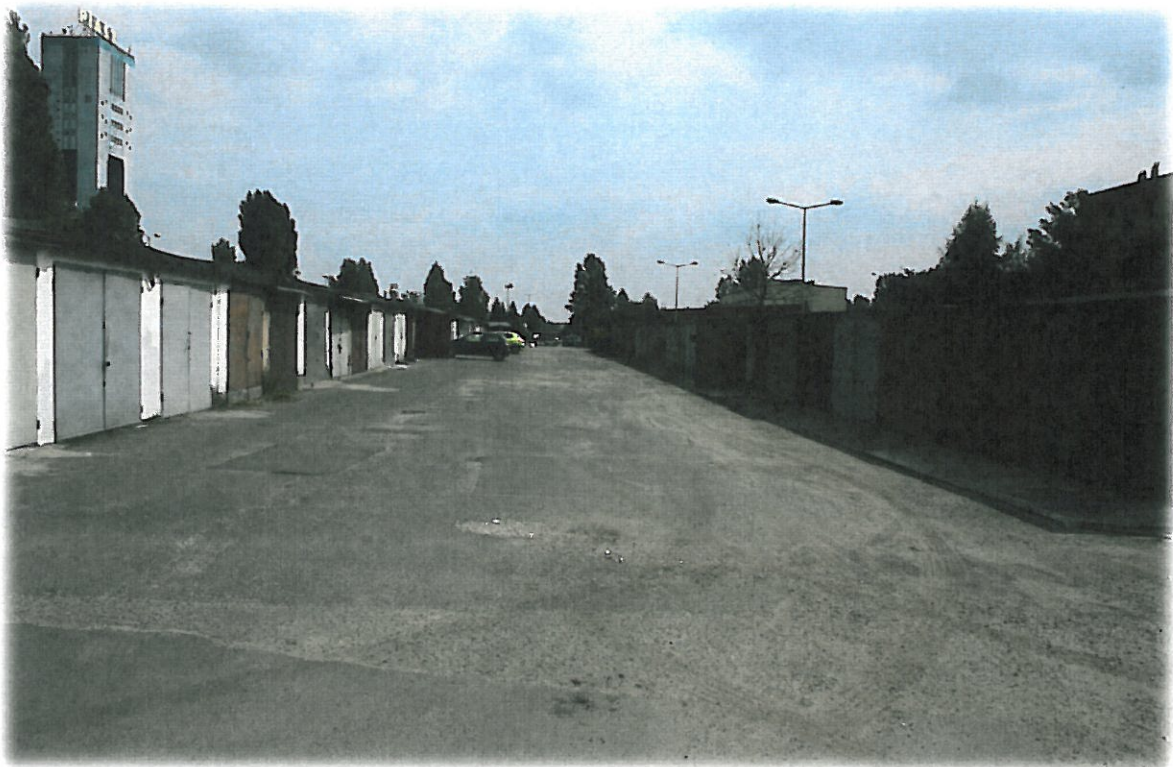
Zdj.16) Garaże - drogi dojazdowe.
