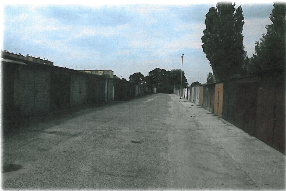
Zdj.9) Garaże - drogi dojazdowe.
