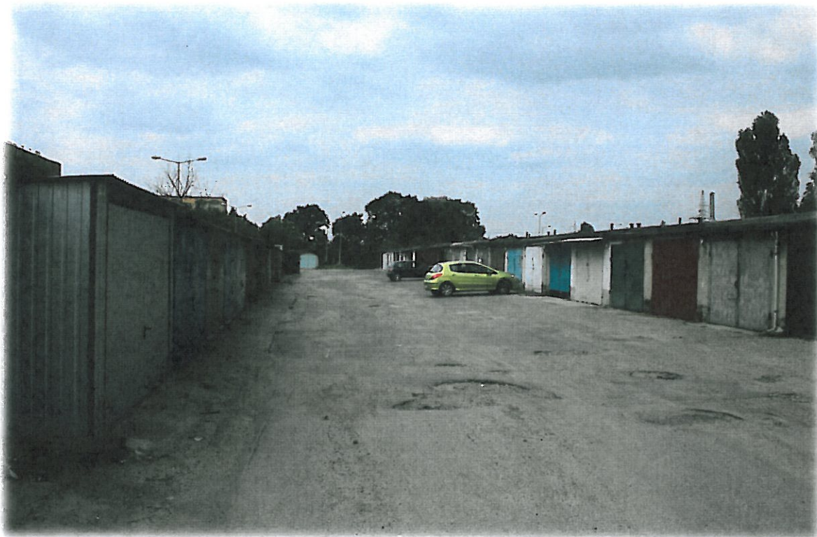
Zdj.1) Garaże - drogi dojazdowe
