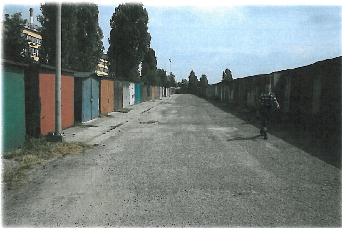
Zdj.13) Garaże - drogi dojazdowe.
