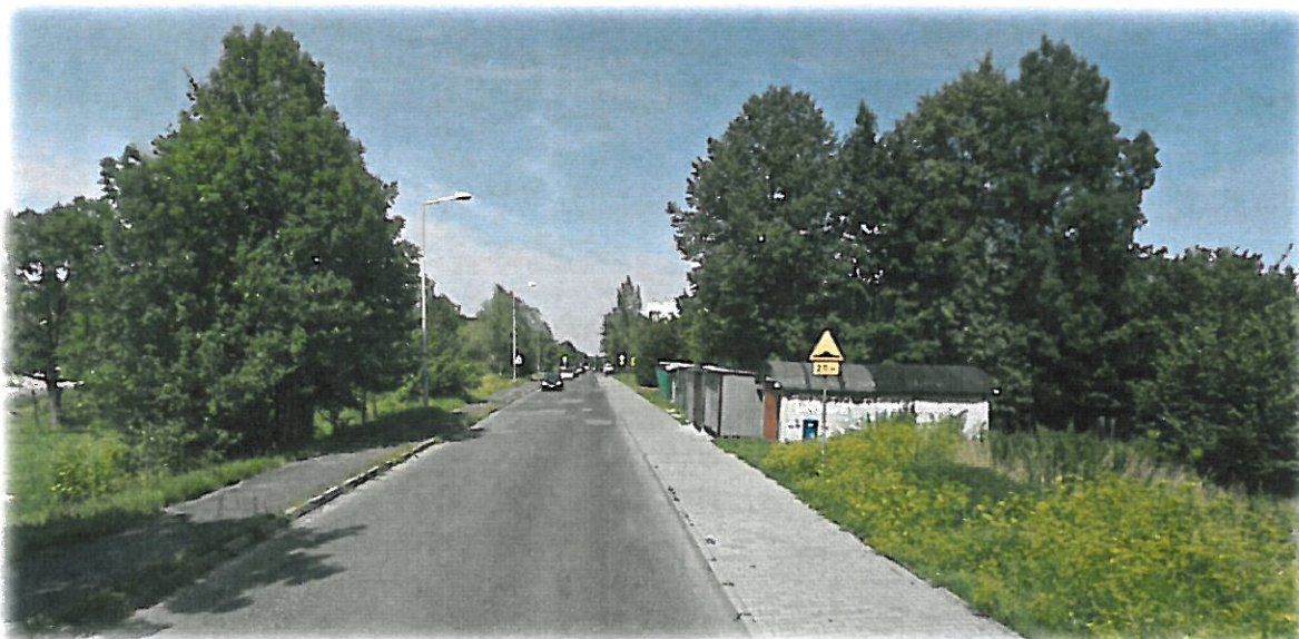
Zdj.3) Ul. Granitowa Km 0+070,00
