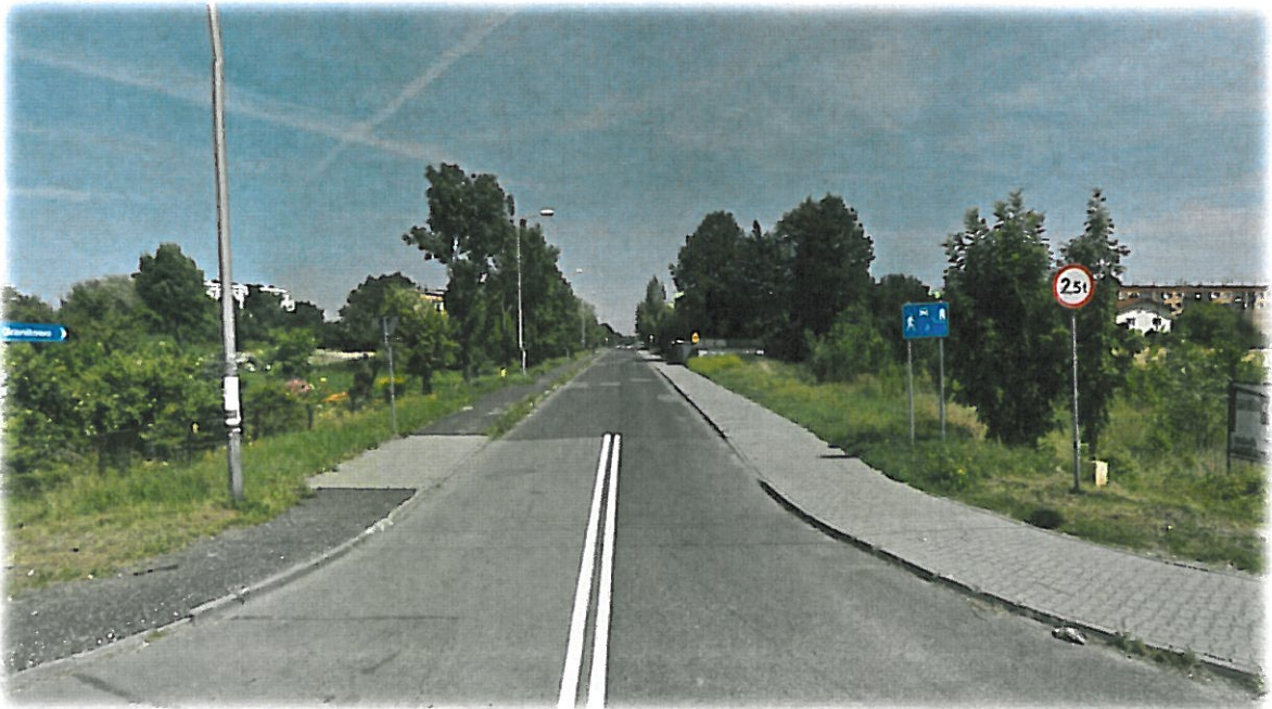
Zdj.2) Ul. Granitowa Km 0+000,00
