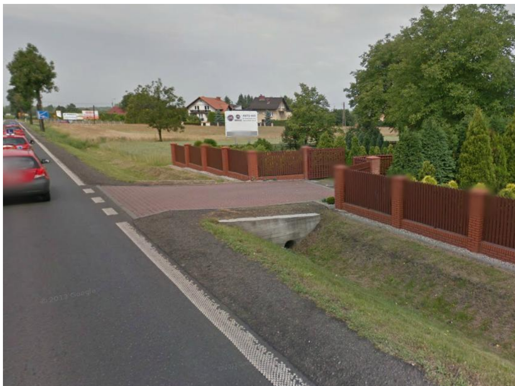
fot.6. Wjazd na posesję budynku nr 13
