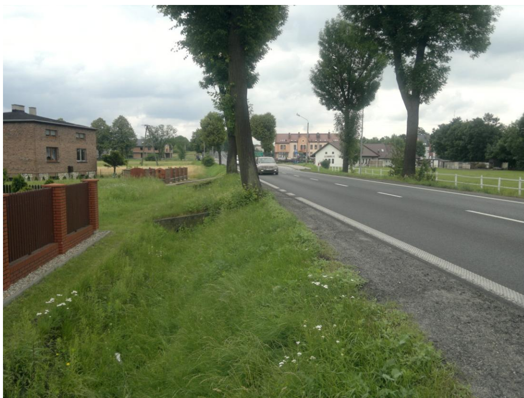
fot.5. Rów przydrożny przy budynku nr 13
