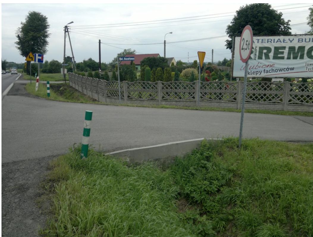
fot.12. Ścianka czołowa przepustu pod ul. Bazaltową
