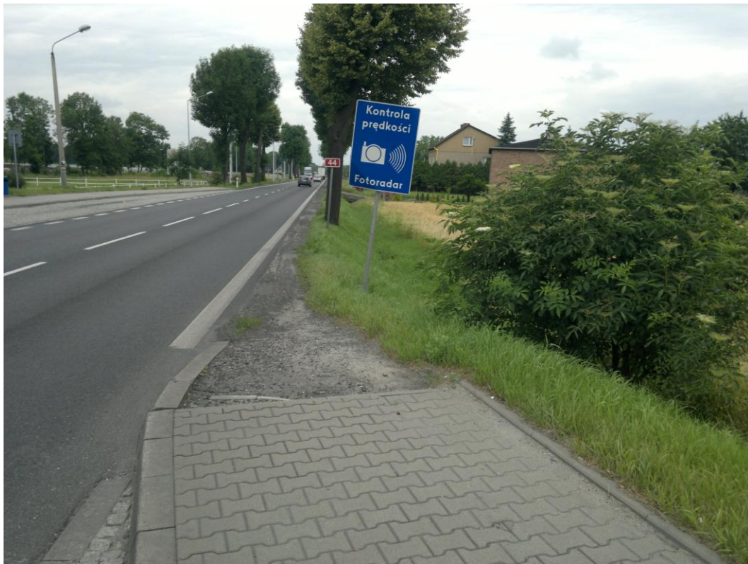
fot.3. Początek opracowania, koniec chodnika z kostki betonowej przy zatoce autobusowej
