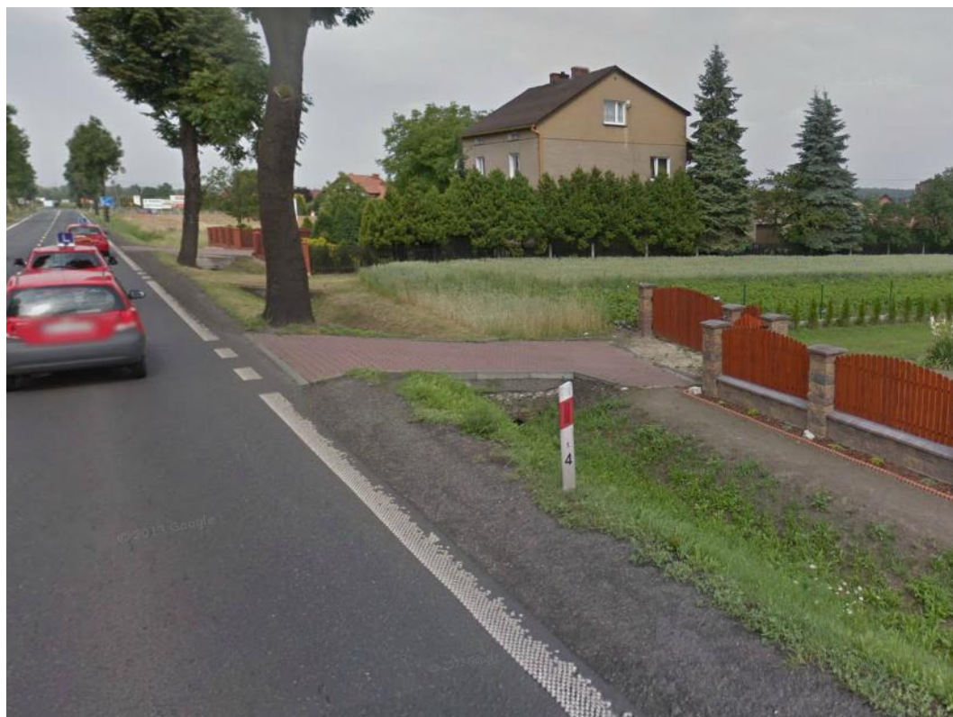
fot.4 Wjazd z kostki betonowej na posesję budynku nr 17
