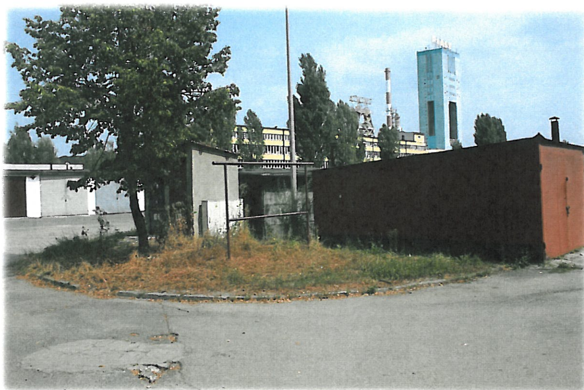
Zdj.21) Garaże - drogi dojazdowe.
