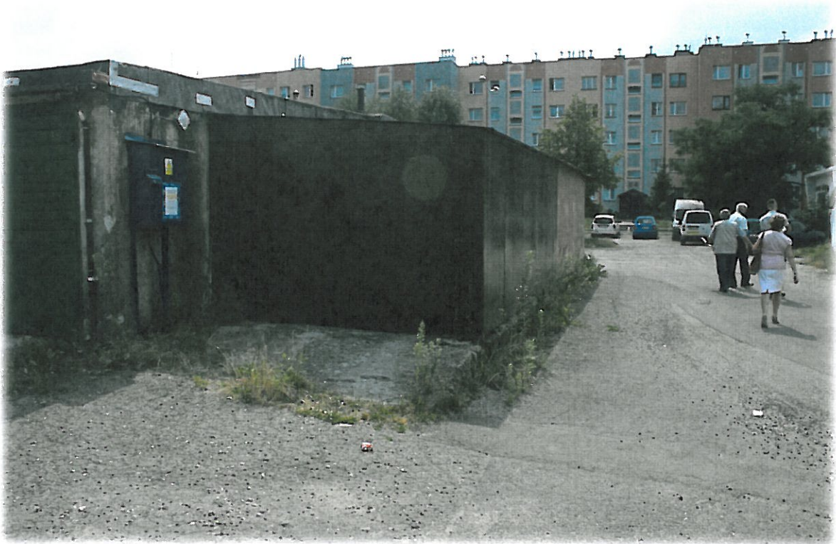
Zdj.11) Garaże - drogi dojazdowe.
