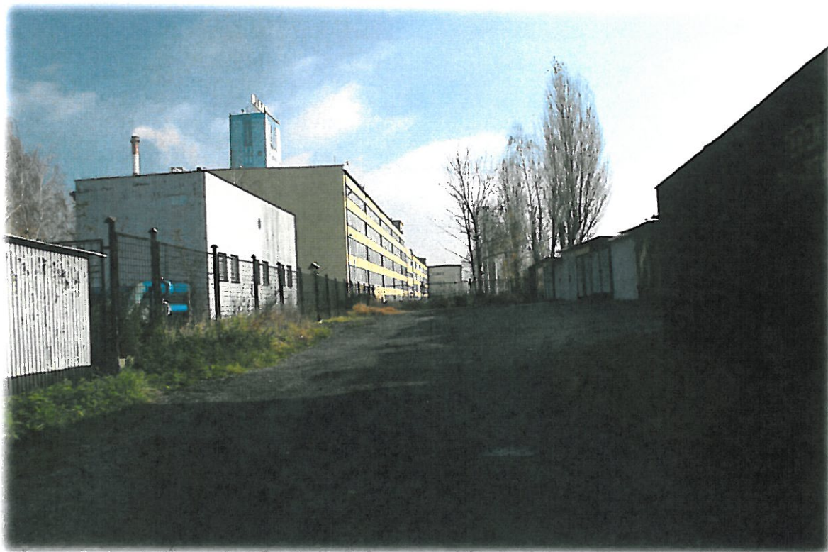
Zdj.27) Garaże - drogi dojazdowe.
