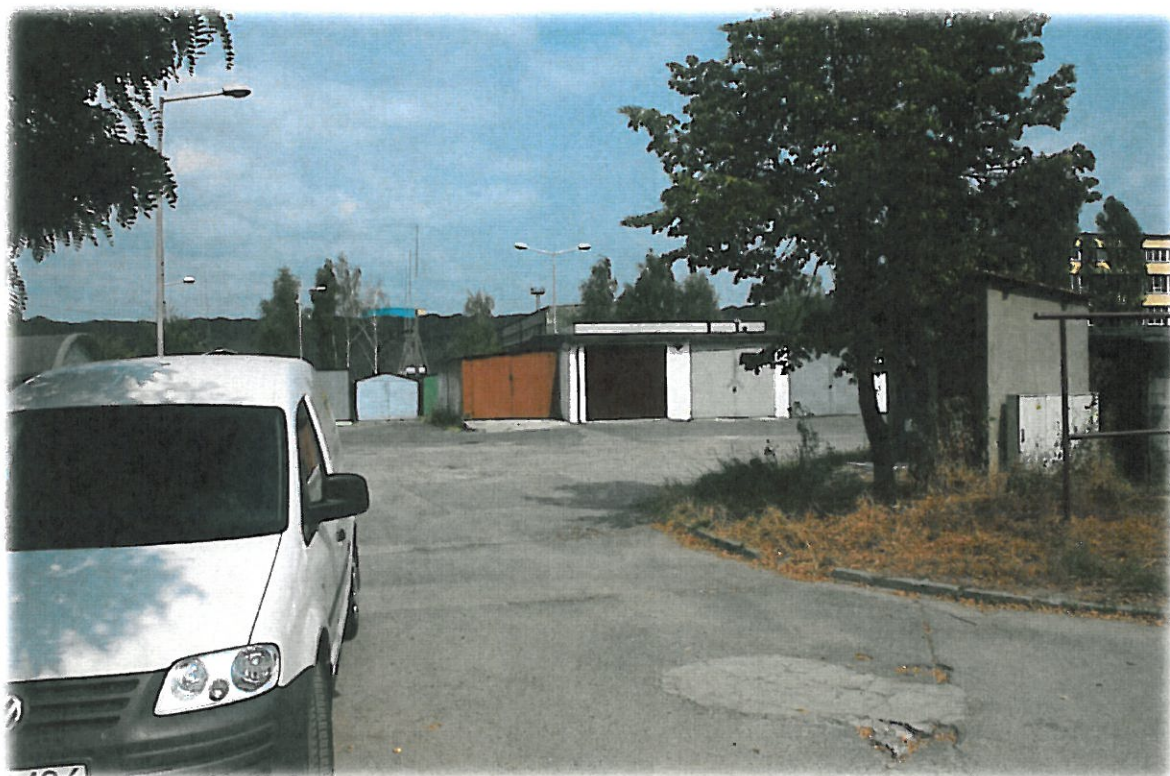
Zdj.22) Garaże - drogi dojazdowe.
